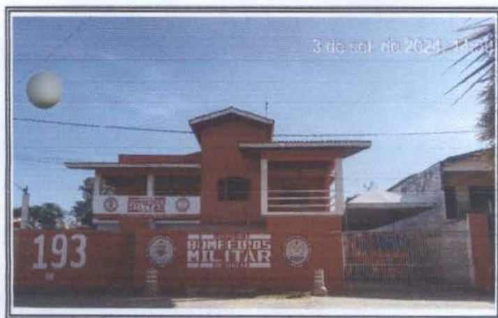
Foto externa - Fachada
